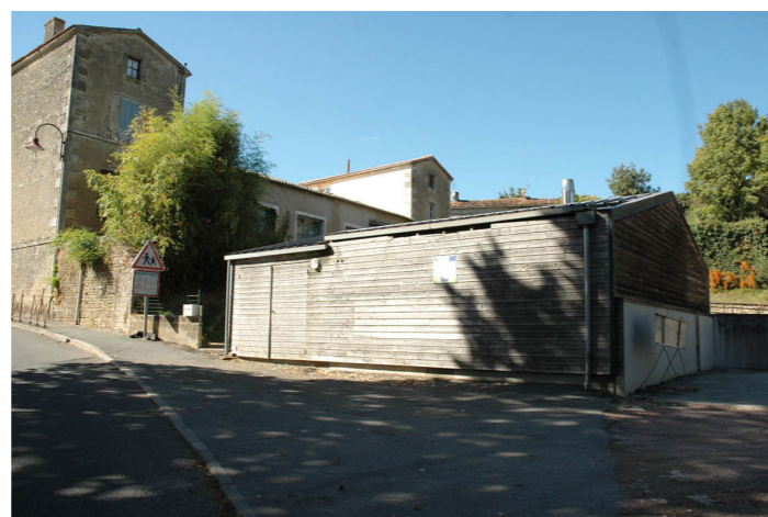
La chaufferie à bois du réseau de chaleur destiné aux équipements communaux d'Ardin
