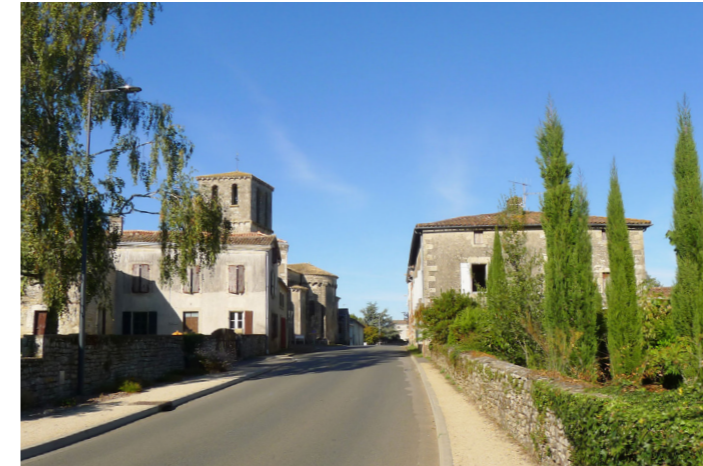
Bourg de Béceleuf, qui s'inscrit dans un bocage localement préservé et des domaines arborés de châteaux.
