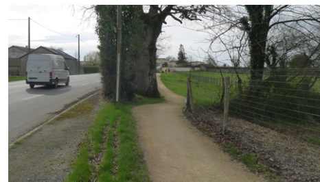
Aménagement de piste cycles & piétons entre Pompaire et Parthenay. Cette piste fortement empruntée s'écarte de la route lorsque cela est possible et s'appuyant favorablement sur le maillage bocager existant pour révéler des vues sur les prés.
