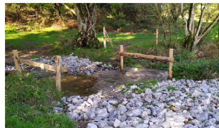
Création d'un ouvrage de franchissement agricole associé aux travaux de renaturation du cours d'eau
