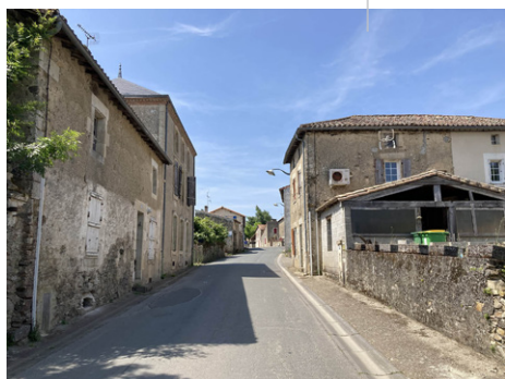
Rue de la Miochette, le trafic de la route départementale influe sur le bâti : fragilisation structurelle, accidents, gestion des eaux
