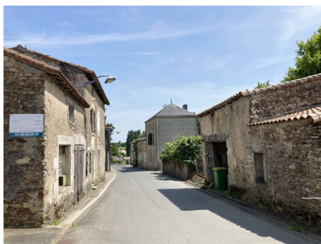
Vacance et abandon : un nombre important de constructions sont en sursis le long des voies principales
