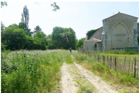
En retrait de l'église Saint-Germain, une prairie inondable révèle par sa topographie l'ancien lit de la Miochette. La commune souhaite installer non loin de l'église un espace événementiel de plein-air
