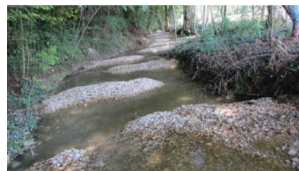
Exemple de reméandrage d'un ruisseau (situation après travaux)
